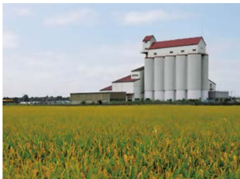
乾燥調製施設「カントリーエレベーター」
